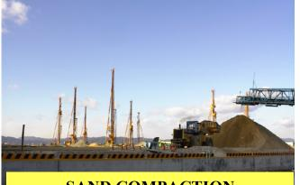
SAND COMPACTION PILE AUGERS
